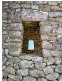
Sl. 21, Stena rustikalne hiše
